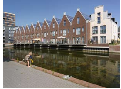
Nieuwbouw en Herstructurering
