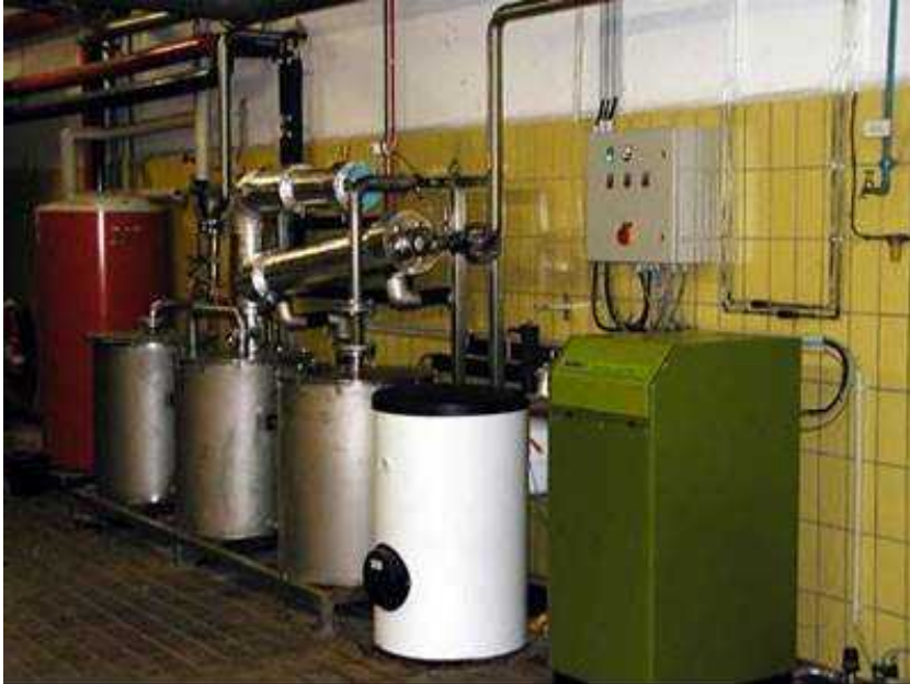
Figuur 6: Gaszuivering bij waterzuivering in Köttingen (Duitsland)
