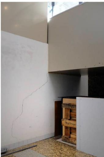
Scheurvorming
