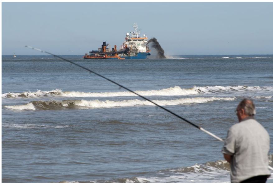
Zandsuppletie bij aanleg Zandmotor Ter Heijde in 2011
