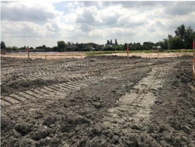
Figuur 2.3 Noordse Leem in een terreinophoging (Roelofarendsveen)
