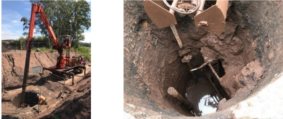
Figuur 21. Uitgraven schacht Melanie (foto's Gemeente Kerkrade).
