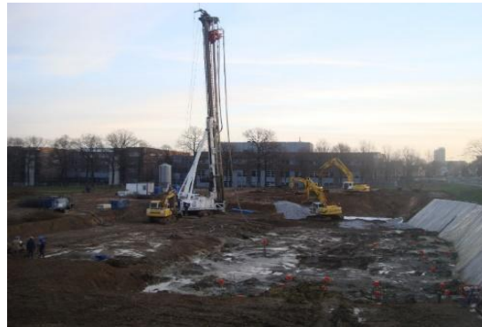
Figuur 30. Nieuwbouw scholencomplex met aangepaste, versterkte fundering.
