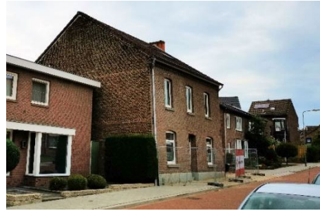
Figuur 9. Woning Bosweg afgebroken en herbouwd.
