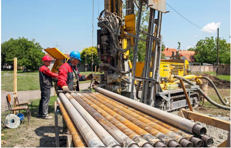
Het aanboren van een geothermiebron. Foto: PureBudget
