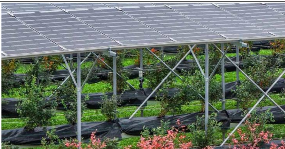
Figuur 7 Voorbeeld van multifunctioneel ruimtegebruik zon-pv: zon i.c.m. bessen-teelt (bron: Stefan Koopmans, Provinciale Energie Strategie - Deel 2 (Limburg))
