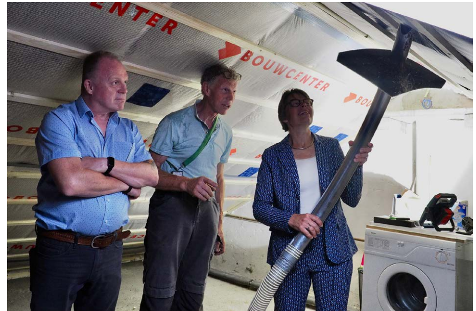
Het inblazen van stro als isolatiemateriaal voor een corporatiewoning
