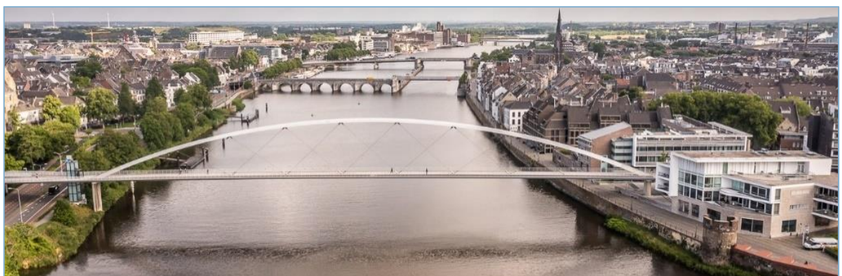
Figuur 3-1 De Hoge Brug in Maastricht
