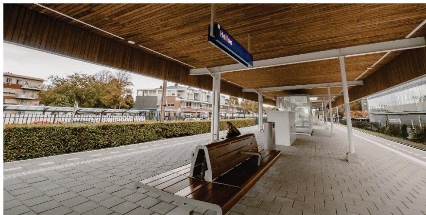
Station Heiloo met nieuwe duurzame perronkap.
