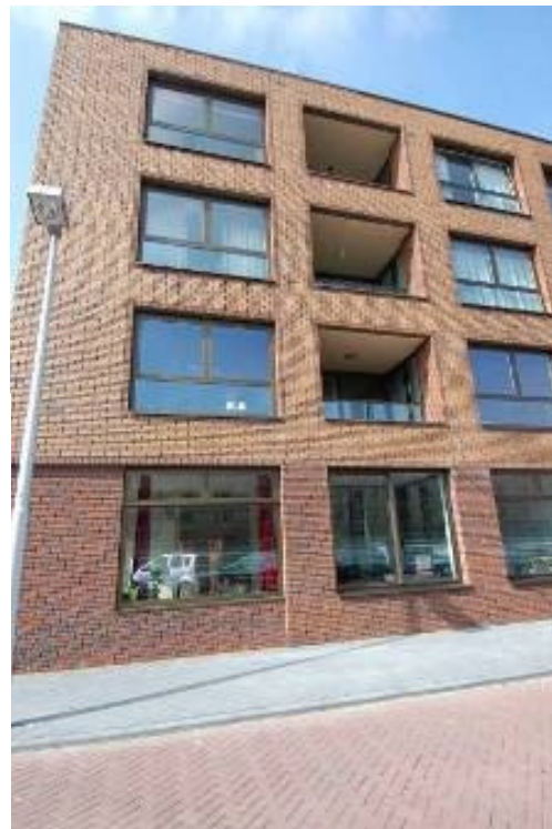
Appartementengebouw in Terwijde met onder andere ADL-woningen
