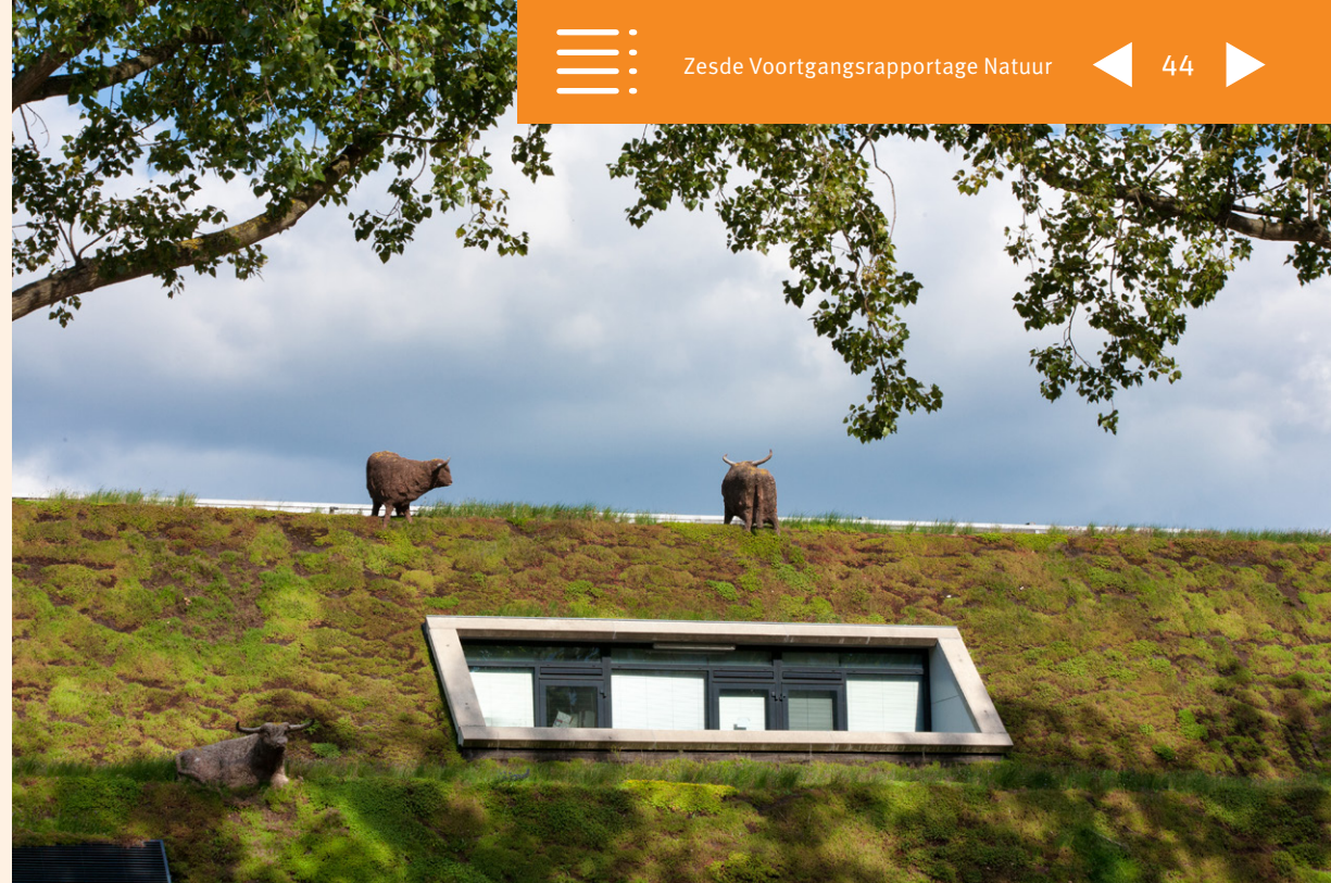
Sedumdak. Foto: Sjon.nl
