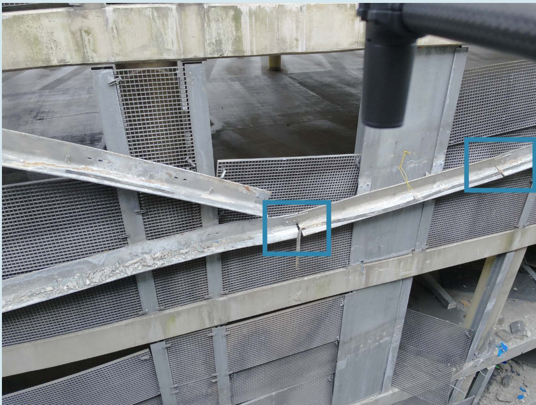
▲ Figuur 13: In delen geknipte ligger met bouten en aangestane plaat. (Bron: Onderzoeksraad voor Veiligheid)
