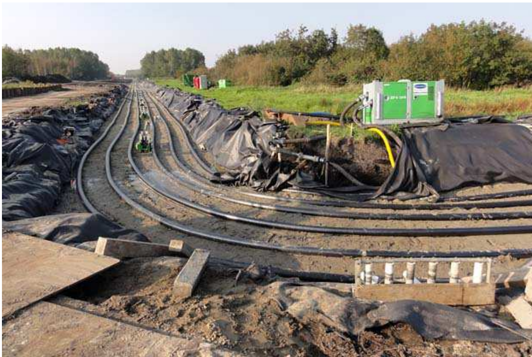
Figuur 13: Foto van de aanleg van 2 circuits met 3 kabels per circuit
