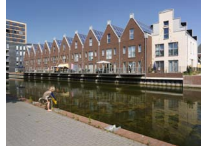
Nieuwbouw en Herstructurering
