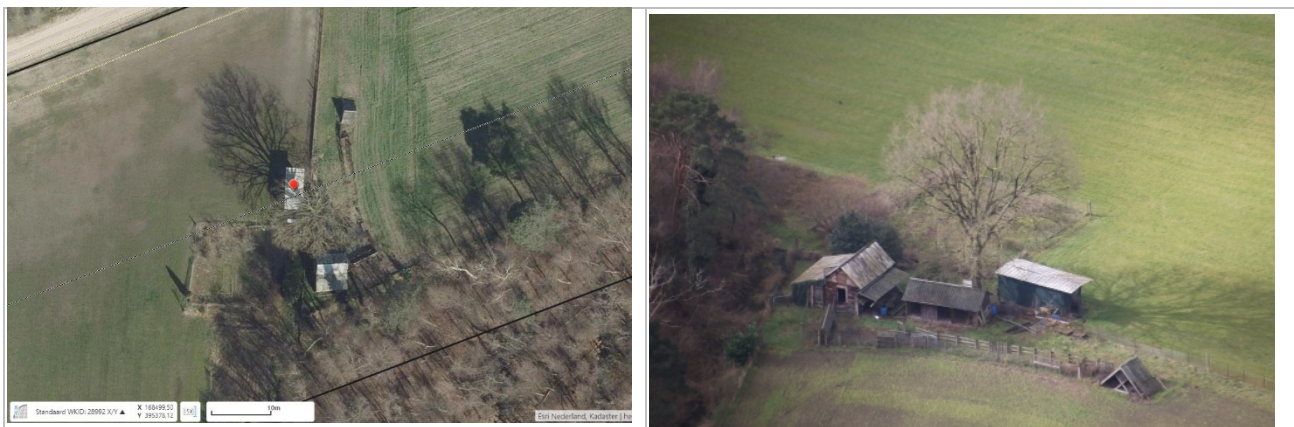
Figuur 19: Links de situatie in gemeente Laarbeek (aandachtspunt ID 113) op de luchtfoto 2020 met een onduidelijk beeld van een aantal panden aanwezig binnen de SVB-strook. Rechts de situatie in maart 2021 vanuit de lucht waargenomen waar de betreffende panden duidelijk gedefinieerd kunnen worden als schuurtjes.
